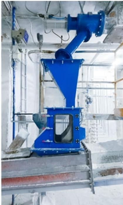
Der Master BulkSlide ist ein Feststoff-Durchflussmesser mit einer hohen Genauigkeit von  $\pm 0,5$  Prozent. Er eignet sich für die meisten festen Schüttgüter, die freifließend und nicht klebrig sind. Der BulkSlide berechnet Produktfluss und Gesamtvolumen, indem er die Kraft des Schüttguts beim Kontakt mit der in die BulkSlide-Baugruppe integrierten gebogenen Plattform misst.
